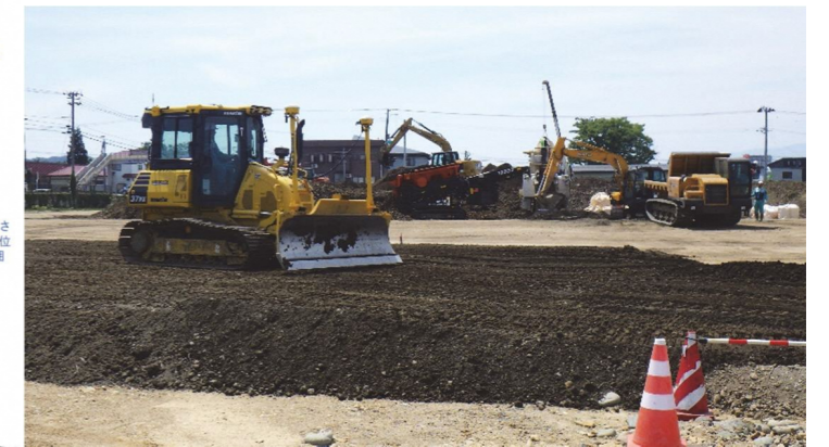
敷地の盛土造成工事状況
